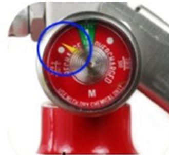
เครื่องดับเพลิง สภาพขัดข้อง (เข็มชี้ช่องแดง)
